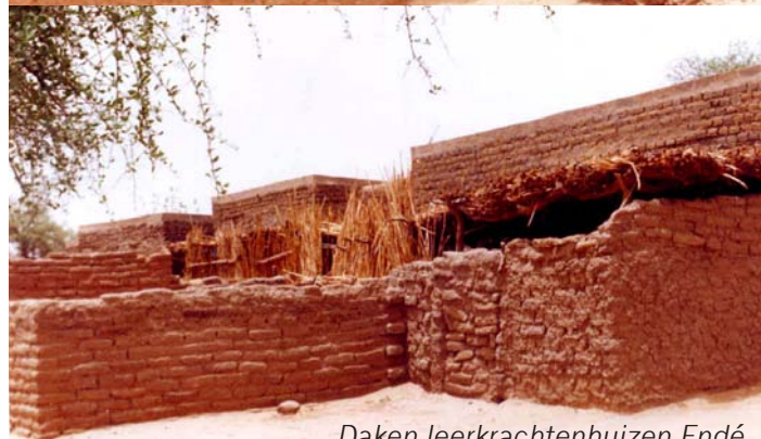
Daken leerkrachtenhuizen Endé
